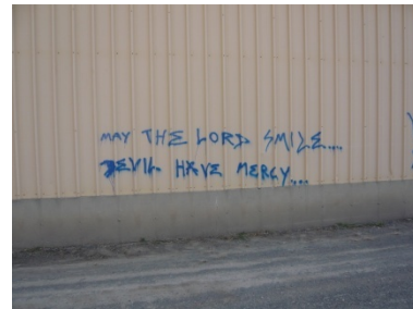
City Shops N. Ingalls St.
